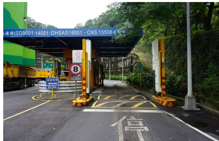
垃圾焚化廠之門框式輻射偵檢器
